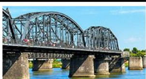
สะพานหวาดถานตง
