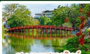
สะพานแสงอาทิตย์
